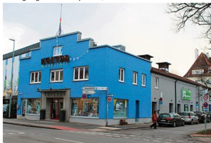
Das historische Stufendach soll erhalten bleiben. Foto: Gattinger
