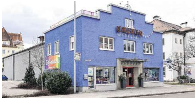
Der Kopfbau der Kulturwerkstatt bleibt erhalten. Der hintere Gebäudeteil wird abgerissen und durch einen dreigeschossigen Neubau ersetzt. Foto: Wild (Archivbild)
