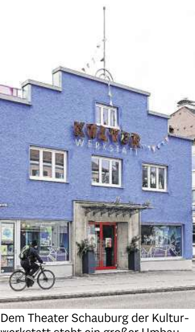
Dem Theater Schauburg der Kulturwerkstatt steht ein großer Umbau bevor. Foto: Mathias Wild (Archivbild)
