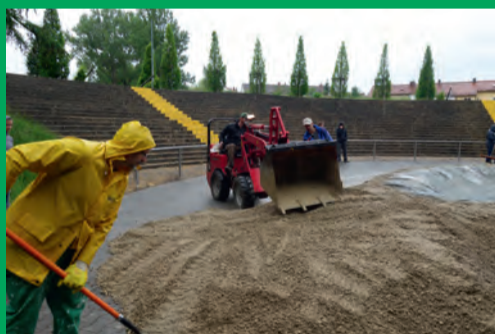
Mit schweren Maschinen schaffen wir das
