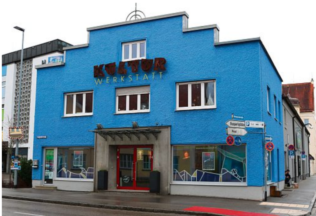
Das Gebäude der Kulturwerkstatt ist in die Jahre gekommen. Nun soll es saniert werden. Foto: Kola
