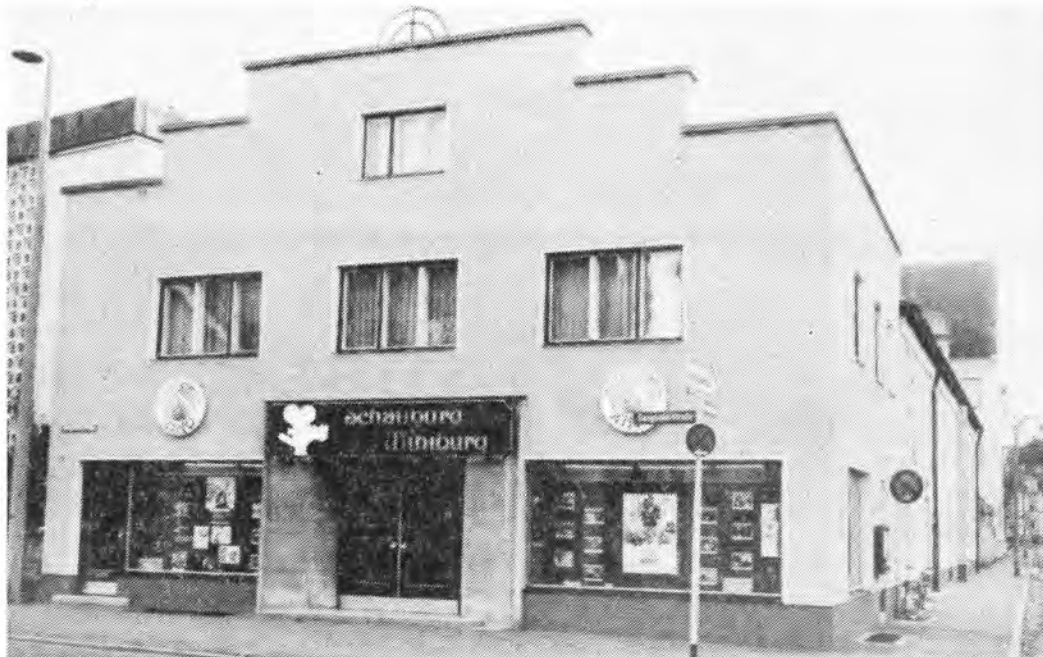
In neuem Gewand präsentiert sich die Schauburg — jetzt mit „Miniburg“.
